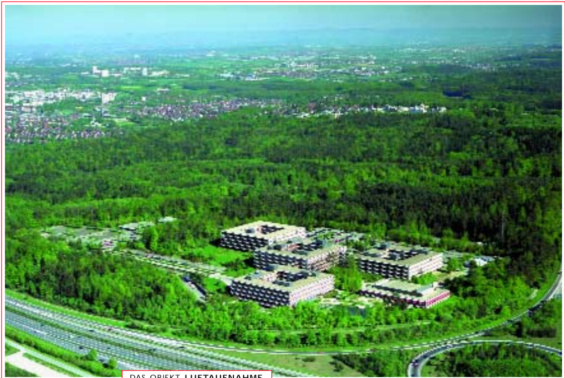
DAS OBJEKT LUFTAUFNAHME
